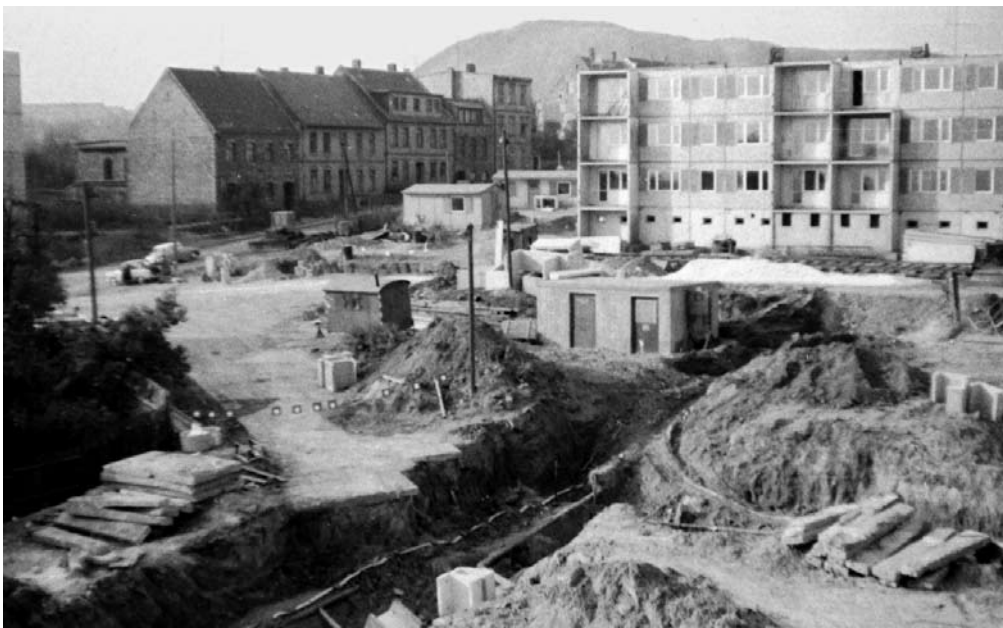
Das Bild entstand um das Jahr 1978 und zeigt im Hintergrund die Häuserreste der alten Helbraer Straße. Oberhalb rechts ist ein Teil des im Bau befindlichen Blockes der heutigen Martin-Rinkart-Straße 1-7 (ehemals Helbraer Straße 56-68) zu sehen, während im Vordergrund die Versorgungsleitungen für die Johann-Agricola-Straße verlegt werden.
