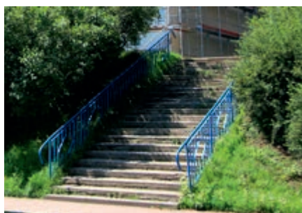
Treppenansicht vor und nach der Sanierung
