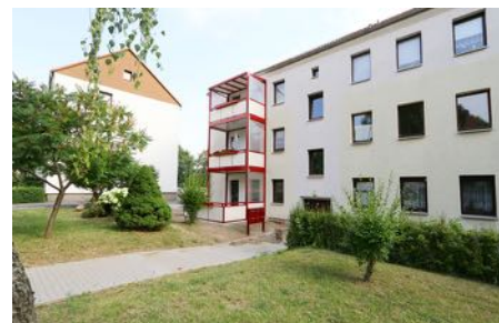
Balkonanlage in der Bergmannsallee 19
