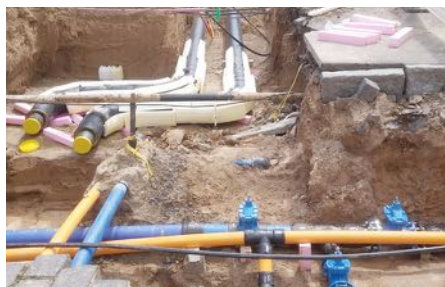
Bau der Fernwärmeleitungen
