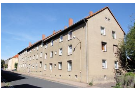
Katharinenstraße 61-63 vor der Sanierung
