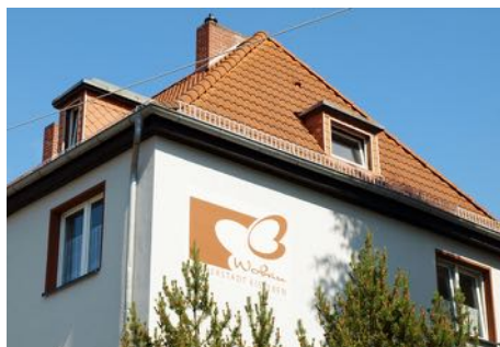
F.-Neißer-Straße 27/28 nach Sanierung
