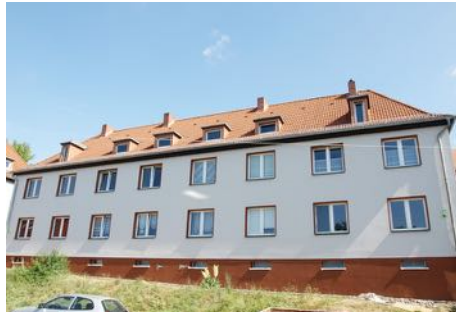
F.-Neißer-Straße 27/28 nach Sanierung
