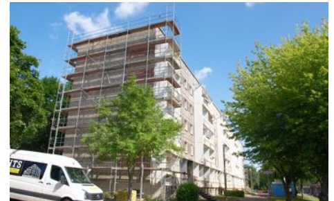
J.-Agricola-Straße 19-21 in Sanierung
