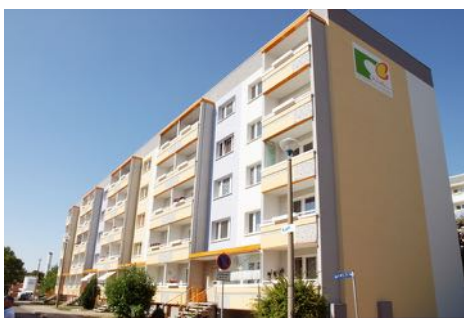
Kurt-Wein-Straße 1-4 nach Sanierung
